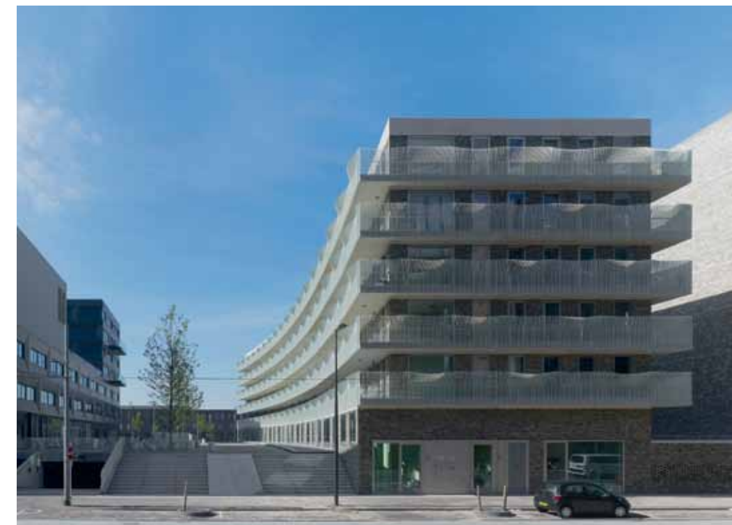
Het leidend principe van Haveneiland 'formele buitenkant, informele binnenkant' streeft Korth Tielens in het ontwerp niet na: Blok 46c geeft ruimte aan een opgetild, informeel plein.
